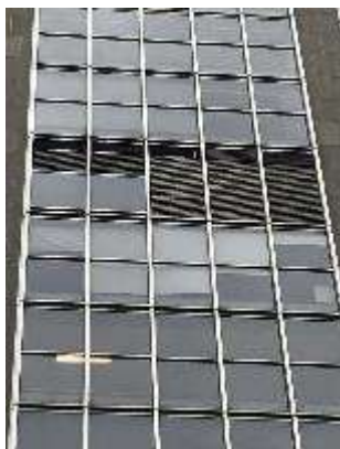
Figura 1 - Faixada do prédio
