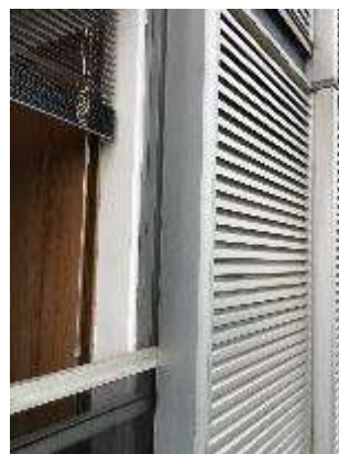
Figura 4 - Detalhe da veneziana - lateral
