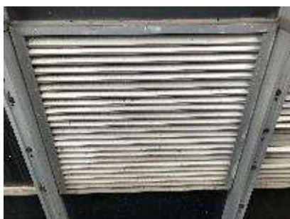
Figura 2 - Detalhe da veneziana - frontal
