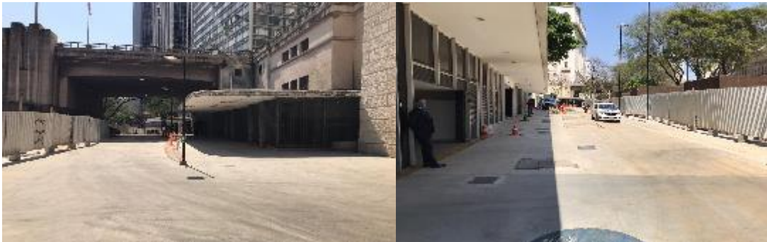
Foto 01: Marquise existente no caminho de acesso ao CEGSP (imagem de 04/09/2020)
